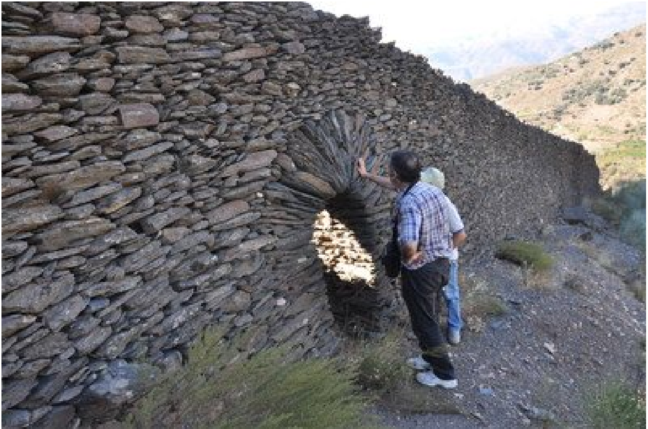
Gran muro alpujarreño con función de paravientos.
