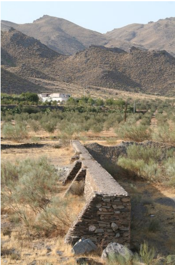
Muro con contrafuertes.
