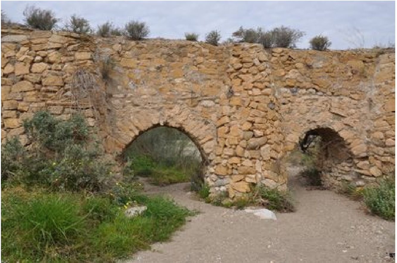
Acueducto en Carboneras.
