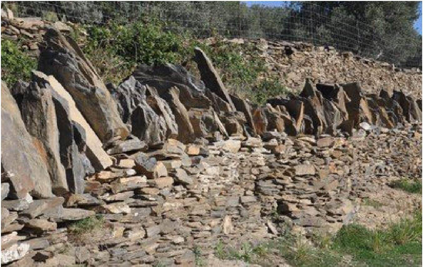
Detalle de la coronación.
