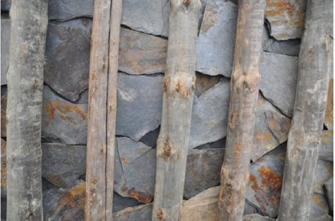
Trama del ensolado visto desde abajo.
