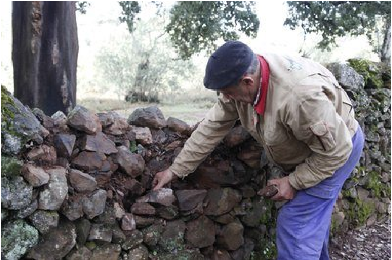
Reparando un muro (Aracena). Autor: Aniceto Delgado.
