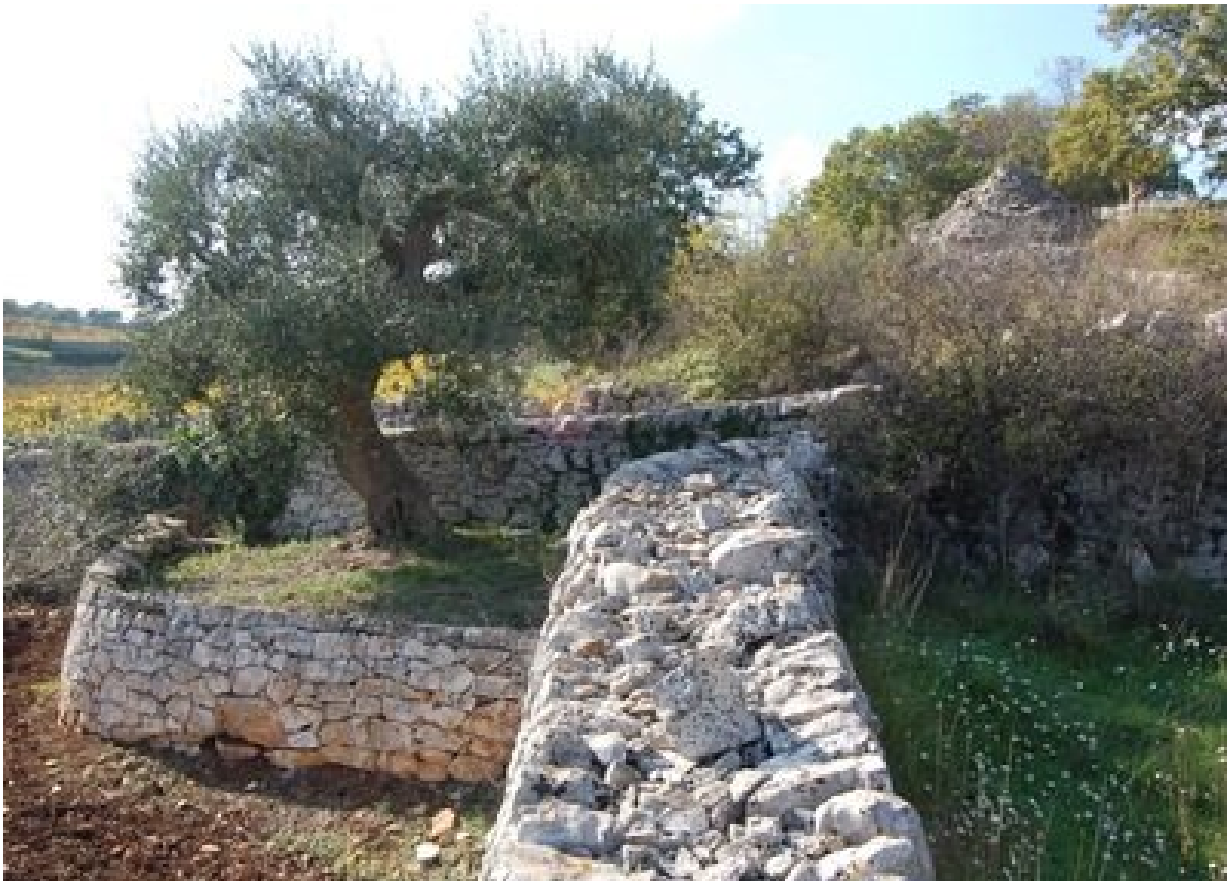
Fig. 3: Des murs bas et lourds retiennent la terre et l'humidité autour de l'olivier encore frêle dans cette campagne de Bari. Ici, de loin, murs, rochers et cultures se confondent (Alberobello, Italie).
