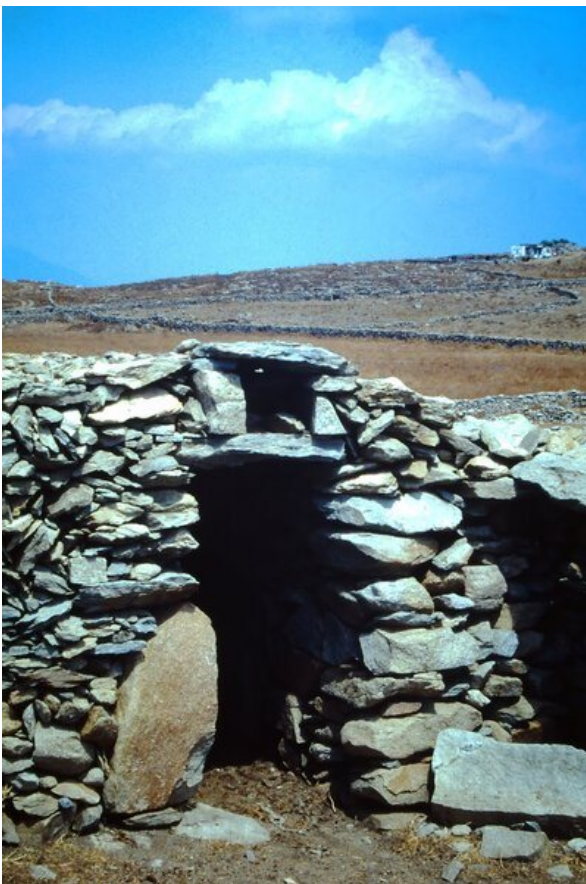
Fig. 7: Au-dessus de l'entrée la niche sert de décharge pour le linteau et de placard pour le menu outillage. Cabane agropastorale sur l'île de Rhenée (Cyclades, Grèce).
