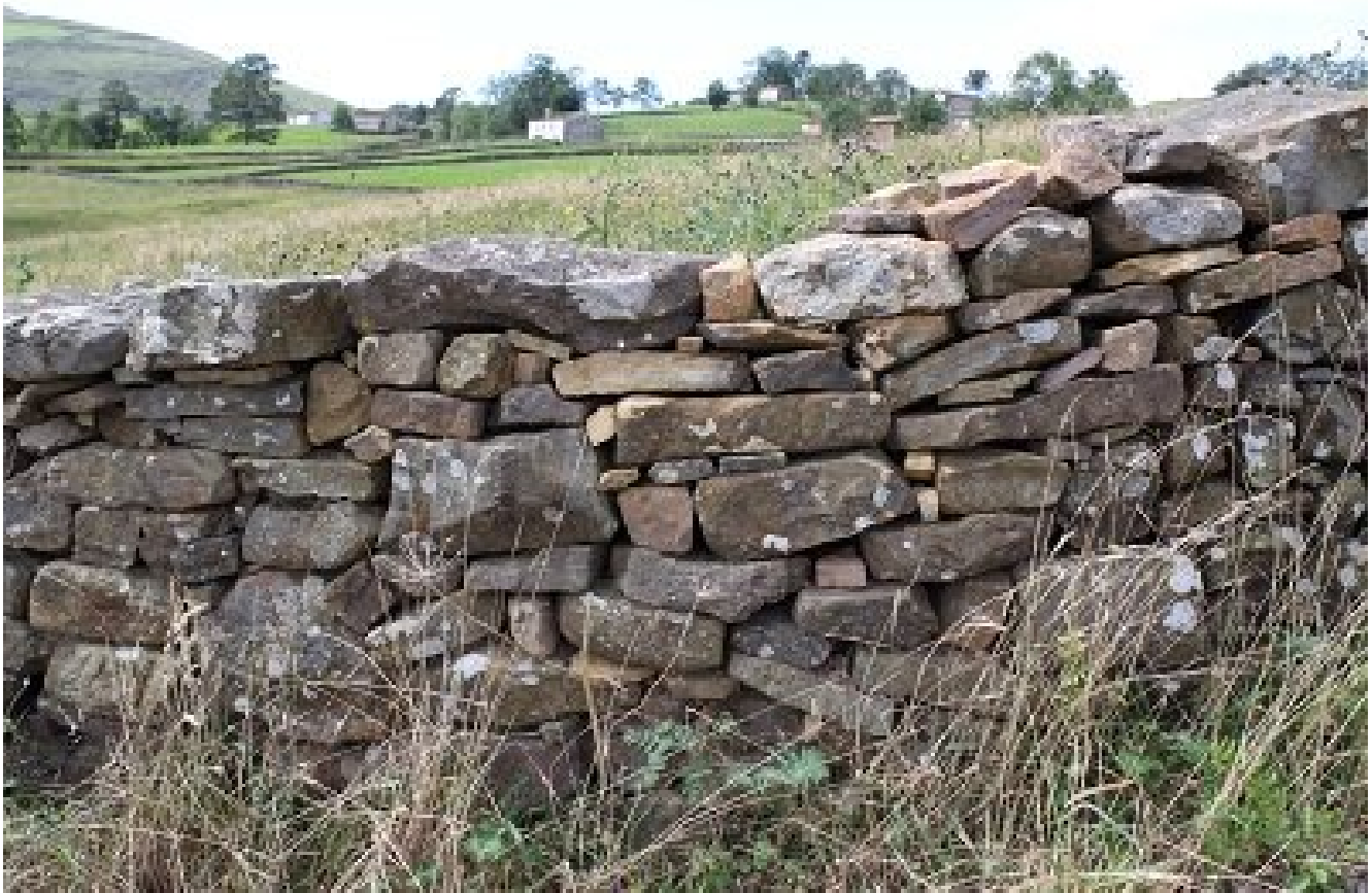
Fig. 8. Muro enripiado en San Pedro del Romeral.
